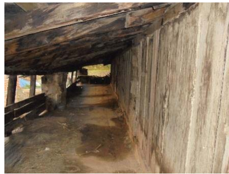
(d) Earthen cover in wooden floor
