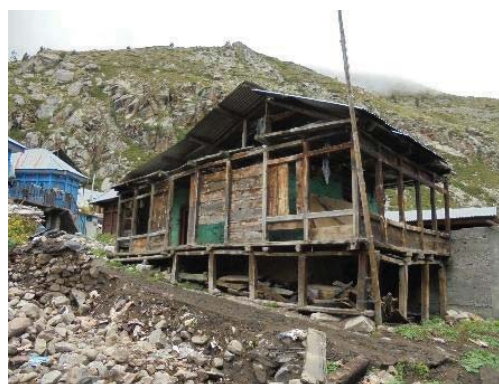
(d) On a raised wooden platform
