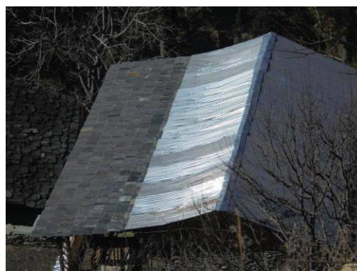
(d) CGI sheets on the roof
