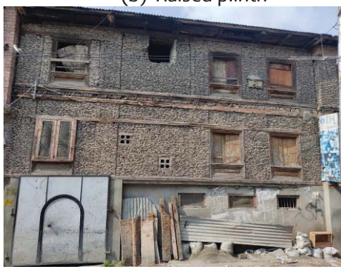
(d) Discontinuous window lintel
