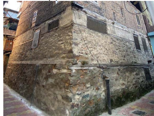
(d) Stone foundation
