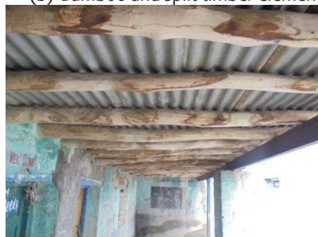
(d) Bamboo girders
