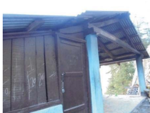
(d) GI sheet as a roof
