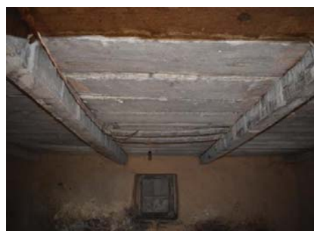
(d) Timber planks on timber floor joists
